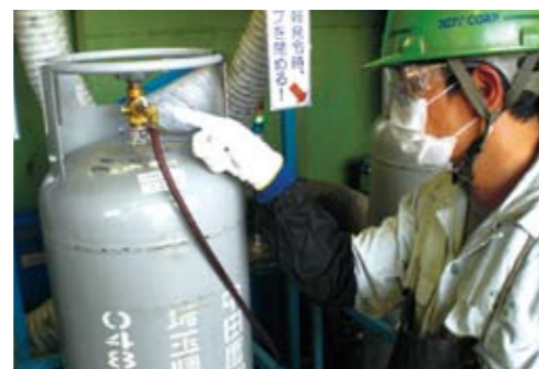
フロン回収 空調機器の冷媒などに使われるフロンは、フロン回収・破壊法によって適正回収が義務付けられています。今年度、中田屋(株)加須工場では、EMSの目標に「フロン漏洩ゼロ」を設定し、達成。確実な処理を実現しています。
