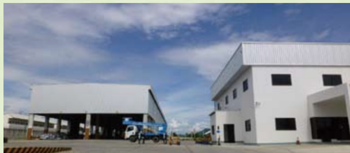
2014年10月の操業開始を目指す現地工場。39,352㎡の敷地内に、1200馬力のシュレッダー、スクラッププレス、天井クレーンなどの設備を備えています。
