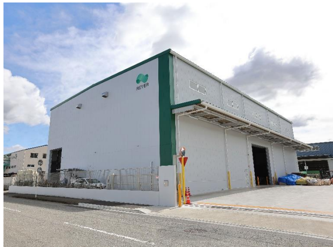
東松山事業所 新工場外観
